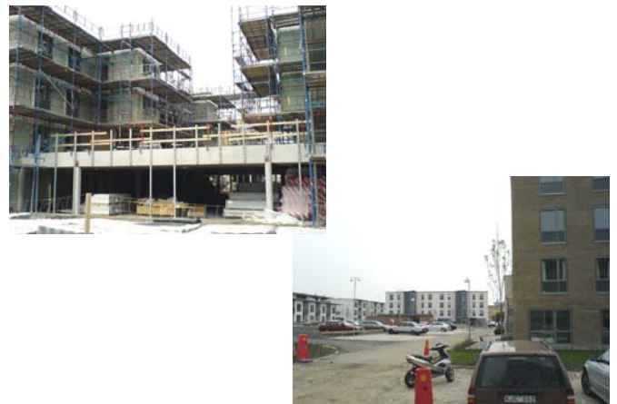
Figur 1. Byggepladsen i Annestad
